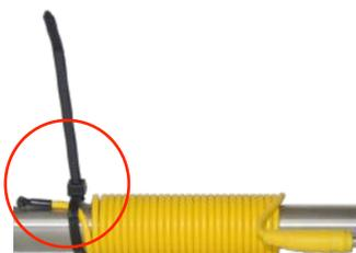
4. Fixer soigneusement les bouts des câbles au tuyau au moyen des attache-câbles en nylon.
